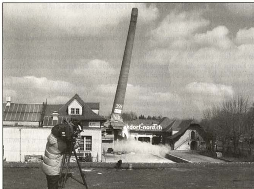
Sekundenbruchteile nach der Sprengzündung wankt der alte Kamin und stürzt in sich zusammen. (Fotos: Rolf Ellwanger)
